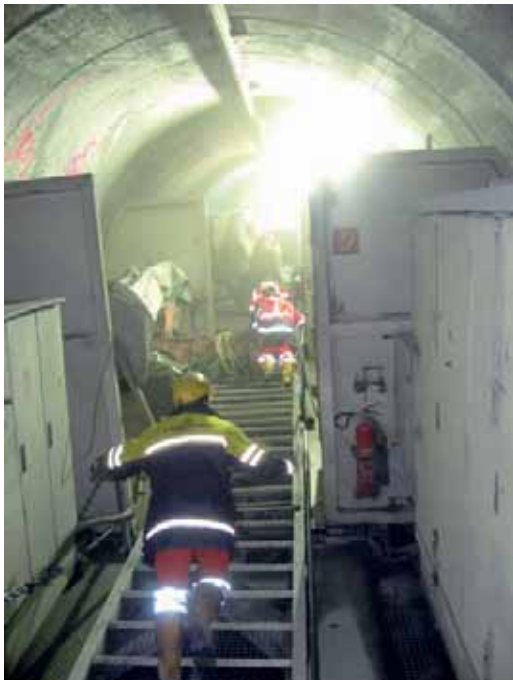
Aufstieg durch die Nachlaufinstallation
