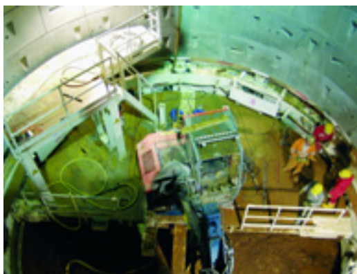
Zentrisch angeordneter Bagger als Aushub-Abbaugerät mit Hammer
