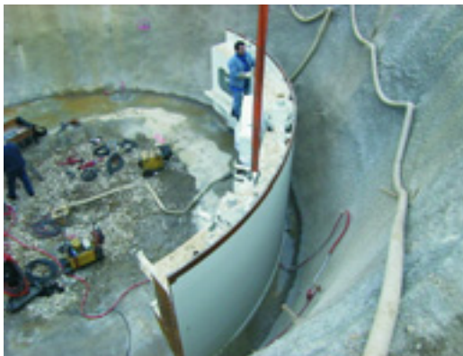
Montage des ersten Elementes
