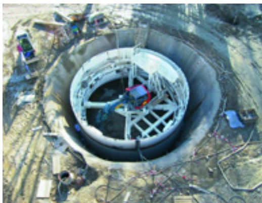
Vormontierter Schild mit Schildschwanz und Aufbauten
