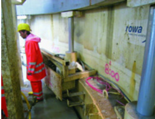
Ausgefahrener Schild bereit zum nächsten Ringbau
