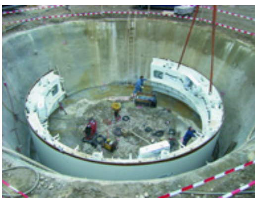
Montage des Doppelmantelschild-Teils
