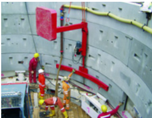
Versetzen eines Tübbings
