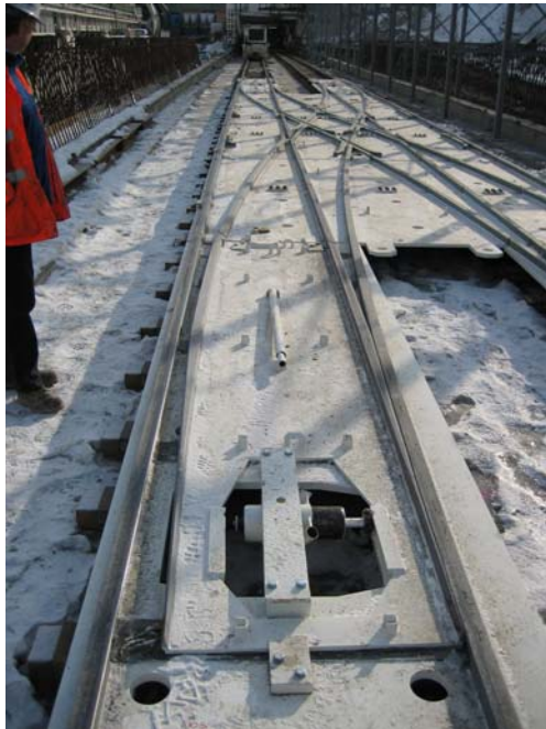
Weiche mit minimalster Bauhöhe
